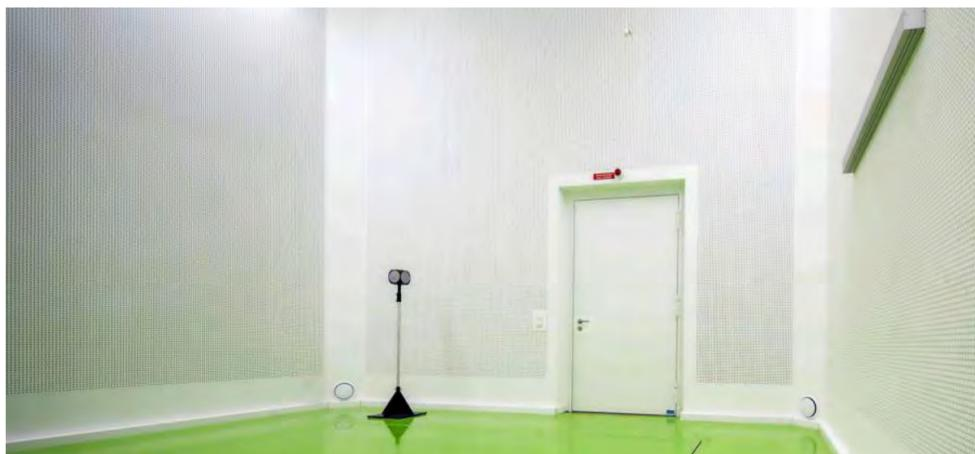
Raum für das Mikroskop „Salve“. Er ist mit Gipskartonplatten ausgekleidet. Sie sorgen für konstante Temperatur und absorbieren Schall.
