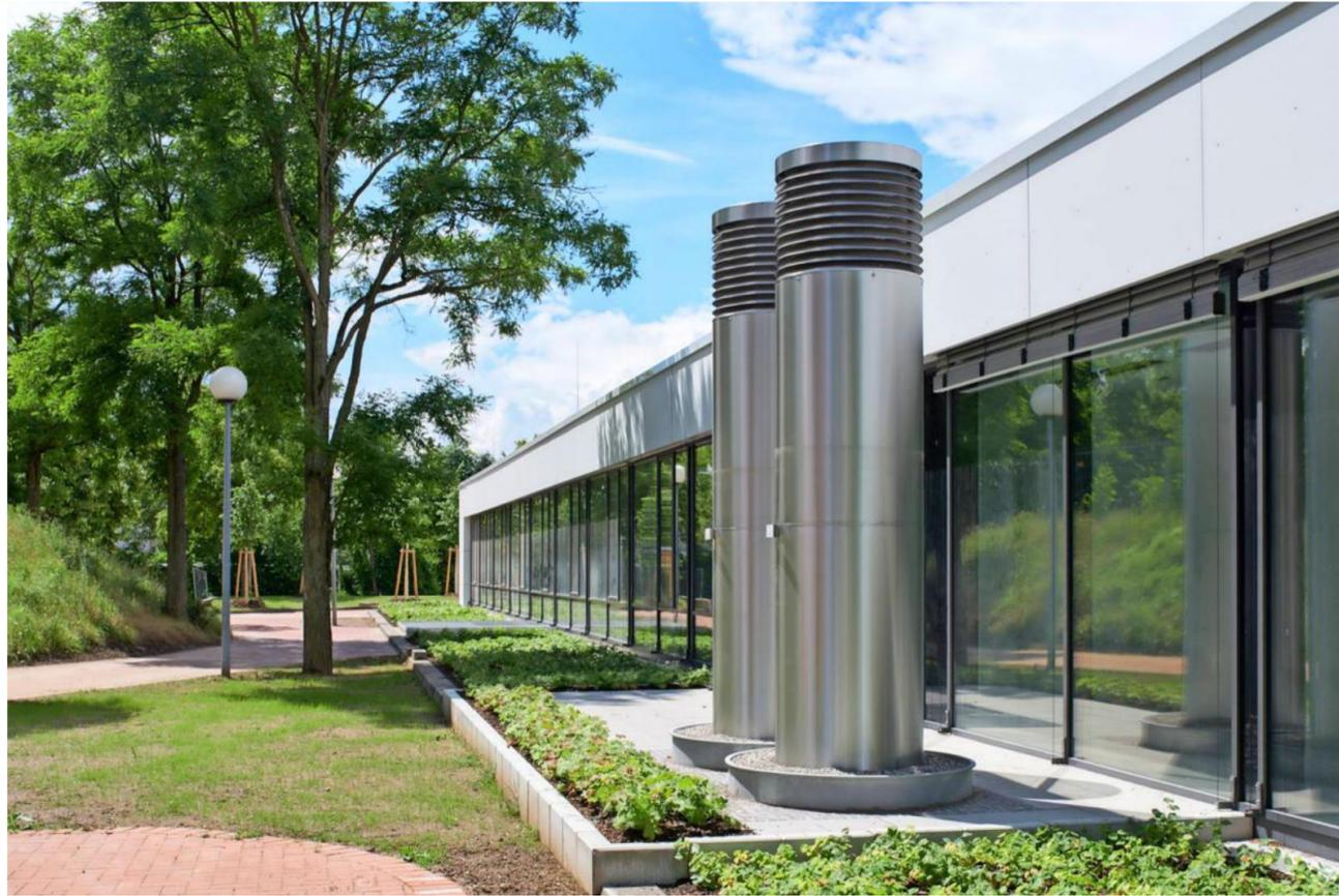
Über die beiden Aussentürme aus Edelstahlrohren am Neubau wird dem Thermo-Labyrinth die Außenluft zugeführt. FOTOS: BILD-RAUM, STEPHAN BAUMANN, KARLSRUHE
