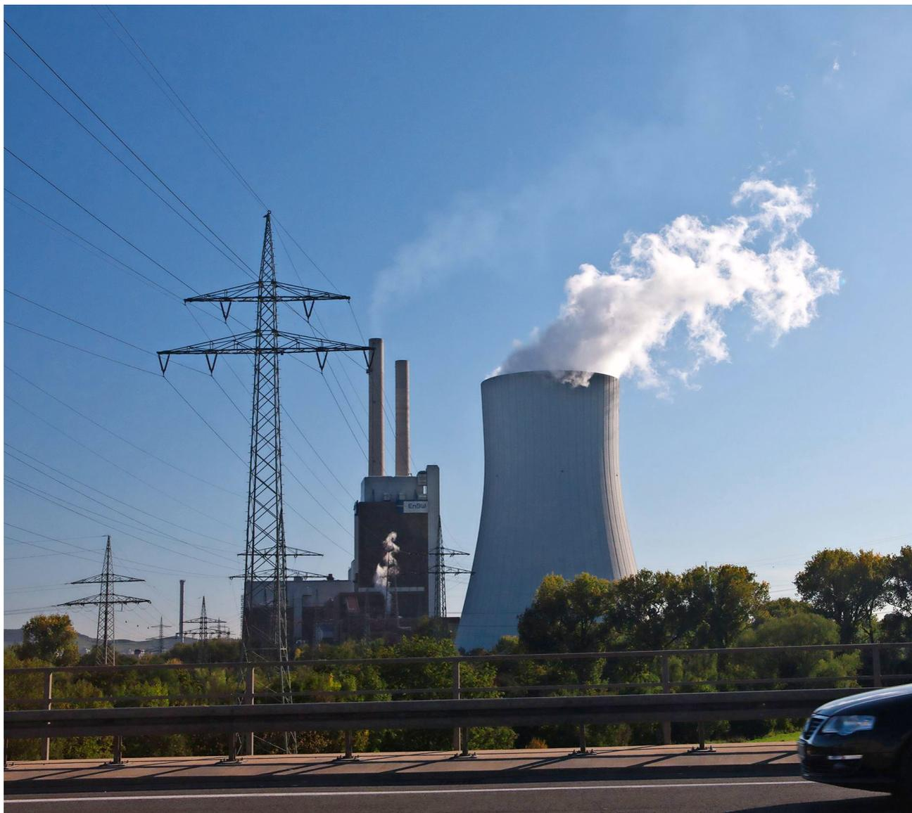
Das Heizkraftwerk Heilbronn gehört mit einer elektrischen Leistung von 1020 Megawatt und einer thermischen Leistung von 300 Megawatt zur Fernwärmeversorgung zu den großen Steinkohlekraftwerken der EnBW. FOTO: DPA
