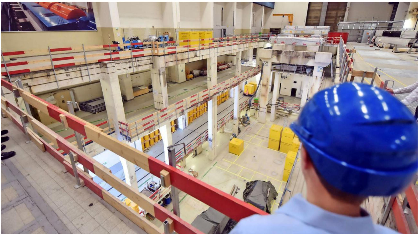
Das Atomkraftwerk in Obrigheim, hier ein Blick in das leere Maschinenhaus, ging 2005 als erstes vom Netz. Der Rückbau soll bis spätestens 2025 abgeschlossen sein. FOTO: ENBW/ULI DECK
