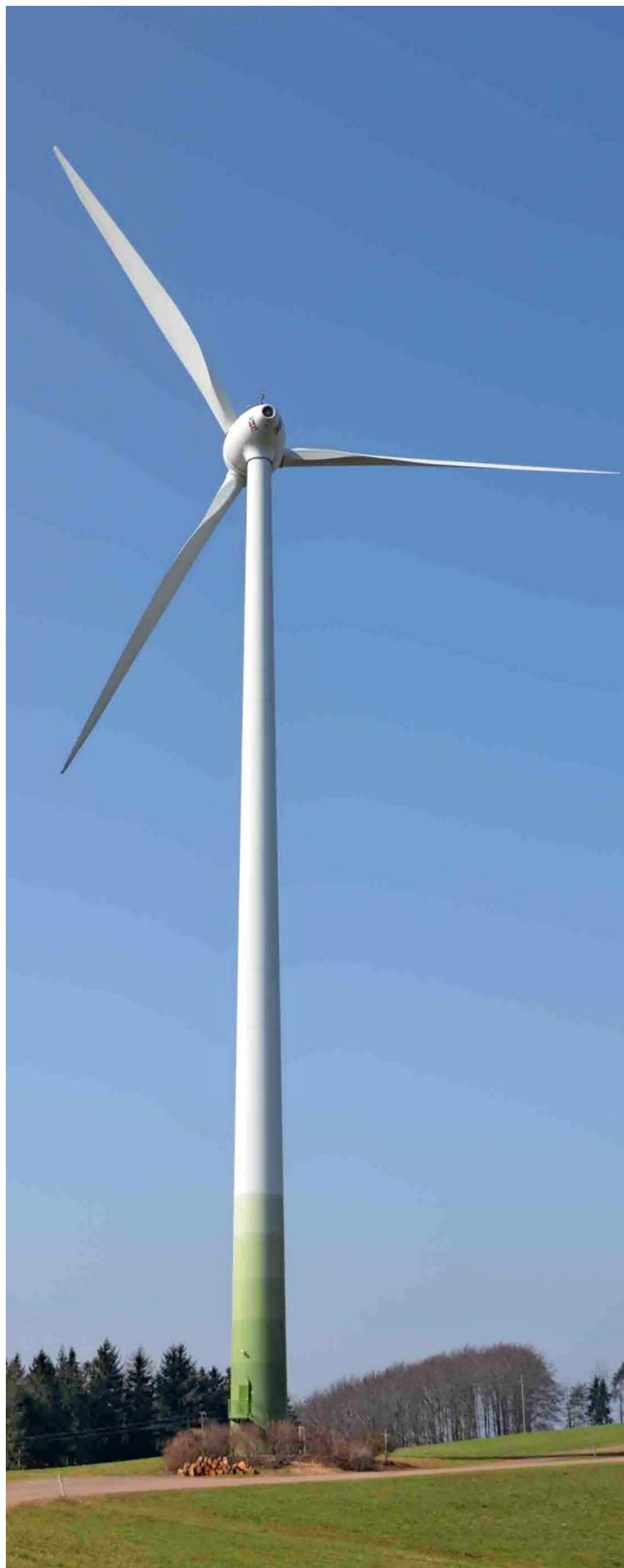
Die Windkraft soll in Baden-Württemberg ausgebaut werden. Für das Jahr 2016 rechnet das Umweltministerium mit dem bislang höchsten Zubau an Anlagen. FOTO: UMWELTMINISTERIUM
