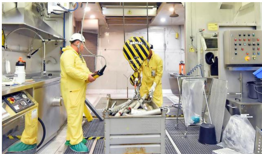
Im Kernkraftwerk Obrigheim bereiten Mitarbeiter im Schutzanzug die Dekontamination abgebauter Anlagenteile vor. FOTO: ENBW/ULI DECK
