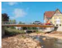
HBV-Brücken Schwäbisch Gmünd Bautechnische Prüfung
