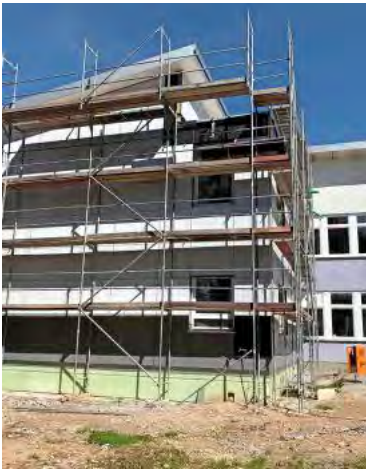
Im neuen Anbau sind vier Klassenzimmer und die Bibliothek untergebracht.
