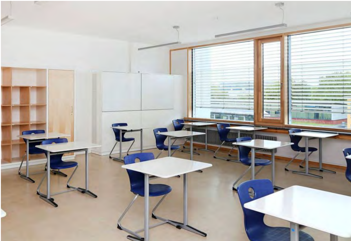
Die neuen Fenster an der Südfassade schließen dicht. Deshalb entschied sich die Stadt für eine Lüftungsanlage in jedem Klassenraum.
