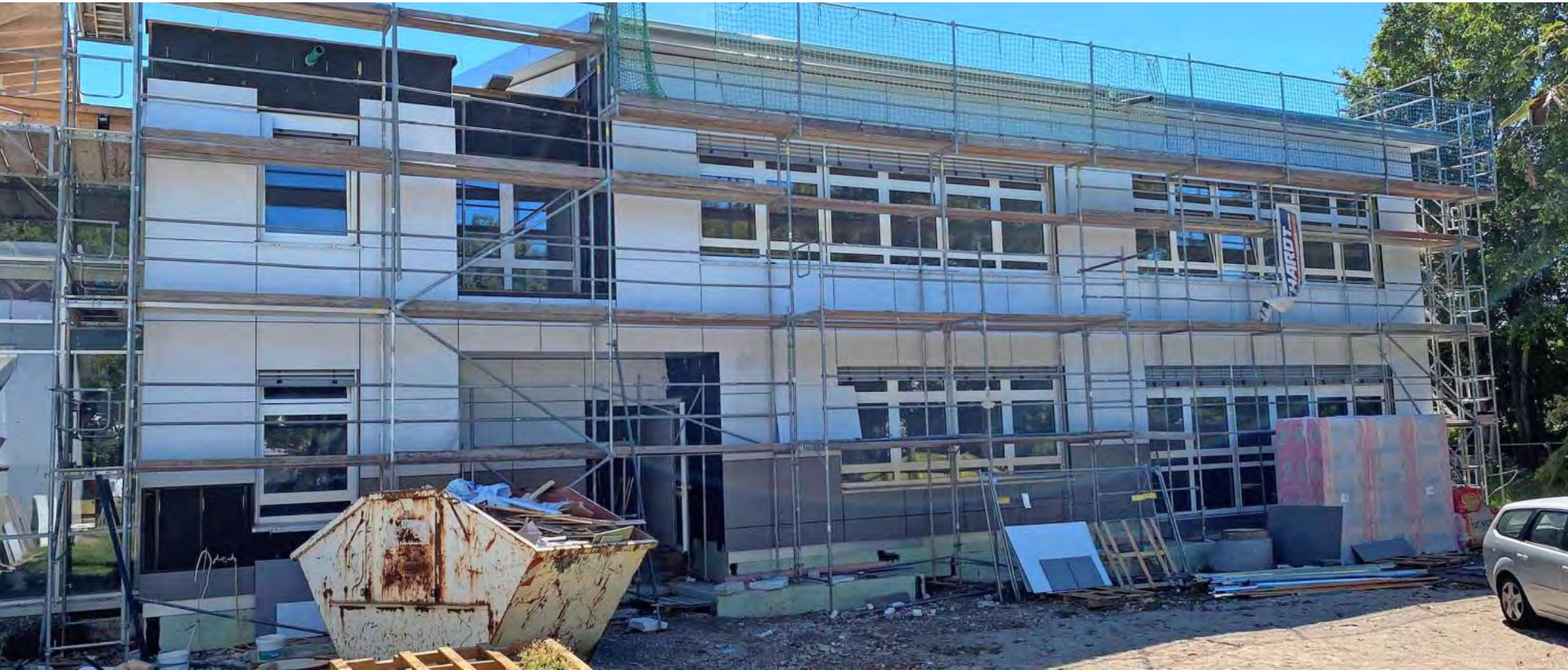
Die Dachneigung des neuen Anbaus an der Astrid-Lindgren-Schule in Ladenburg wurde während der Bauzeit angepasst. So soll die geplante Photovoltaikanlage auf dem Dach mehr Sonne einfangen. FOTOS: SALINGER + PARTNER
