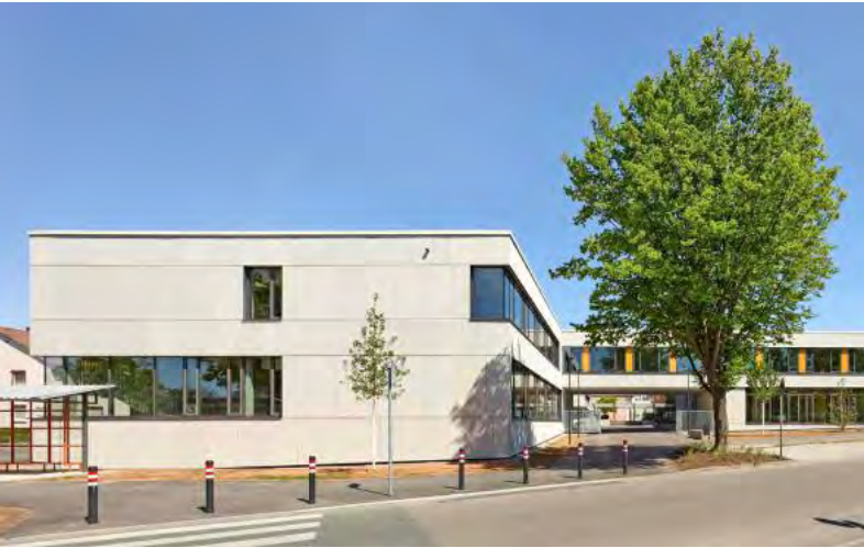
Brüstungs- und Verglasungsbänder prägen die zwei neuen Gebäude an der Westseite der Waldschule. Durchlaufende Fugen binden den Gesamtbaukörper optisch zusammen.
