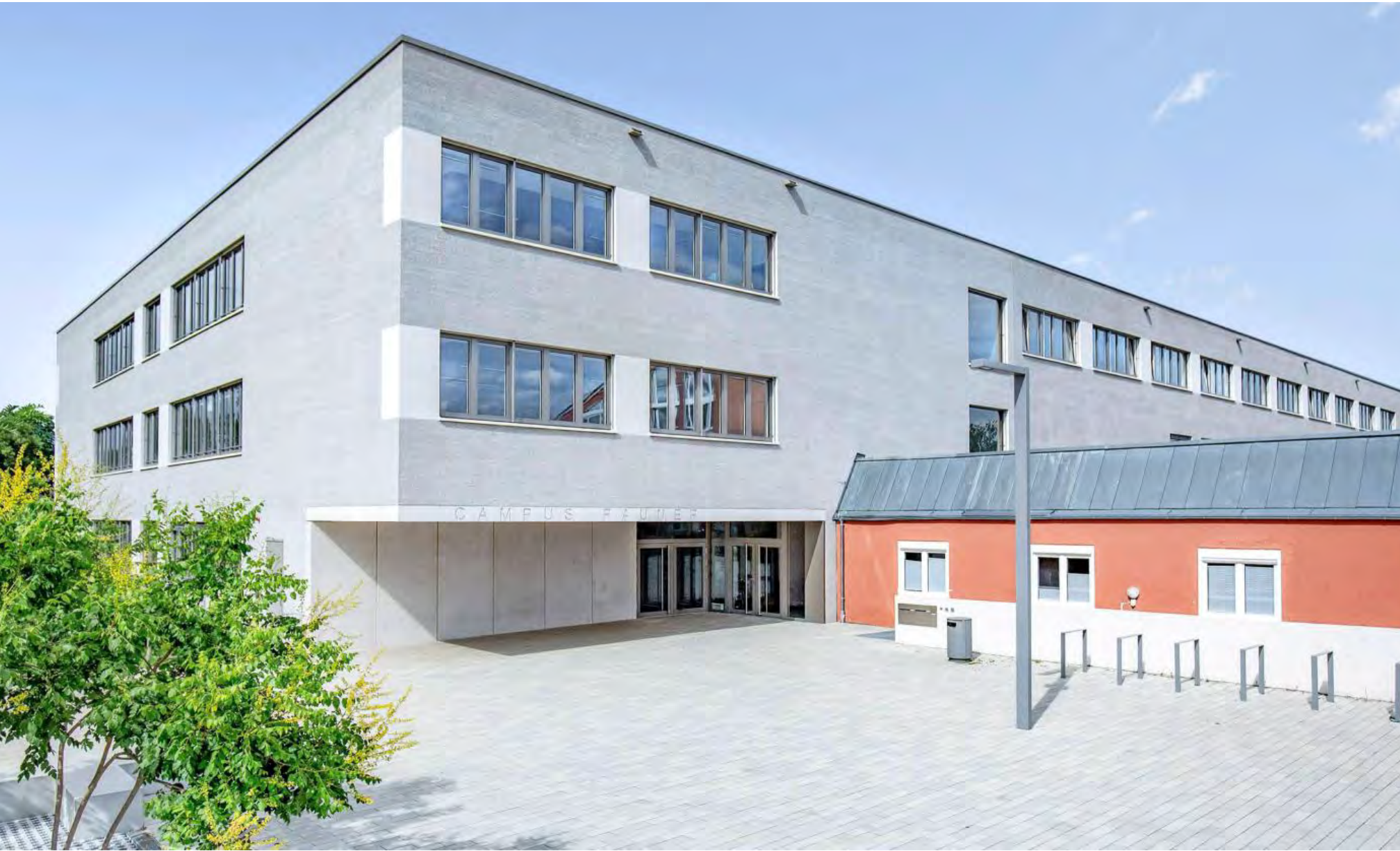
Der Glattputz zwischen den Fenstern und den Laibungen am Neubau auf dem Campus Rauner hebt sich von der lebhaften Struktur des Putzes des sonstigen Gebäudes deutlich ab. FOTOS: STADT KIRCHHEIM
