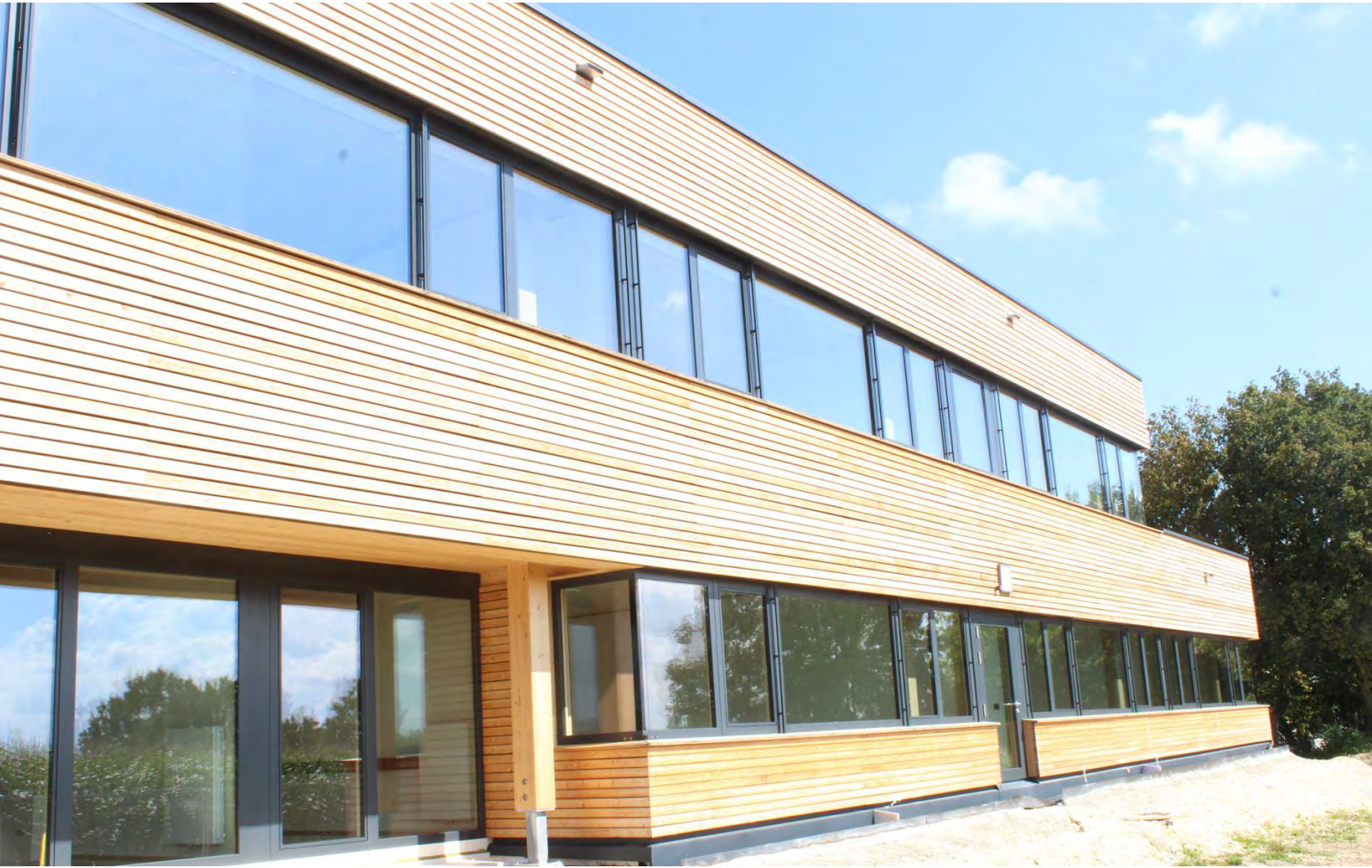
Als Grundgerüst für den neuen Anbau der Weihungstalschule in Staig dient ein Tragesystem aus Baubuche. Die Fassade besteht aus einer Lärchenholzschalung. FOTOS: FARTHOFFER ARCHITEKT
