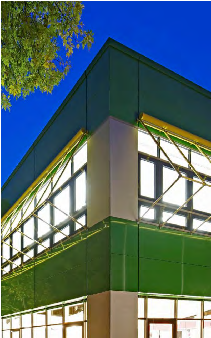
Neue Dreifach-Verglasung, gedämmte Fassade, außenliegender Sonnenschutz: So zeigt sich die grüne Schule nach der Sanierung. FOTO: PETER KREPELA
