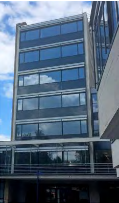
Die Sanierung des Hochhauses erfolgt bereits seit dem Jahr 2014.
