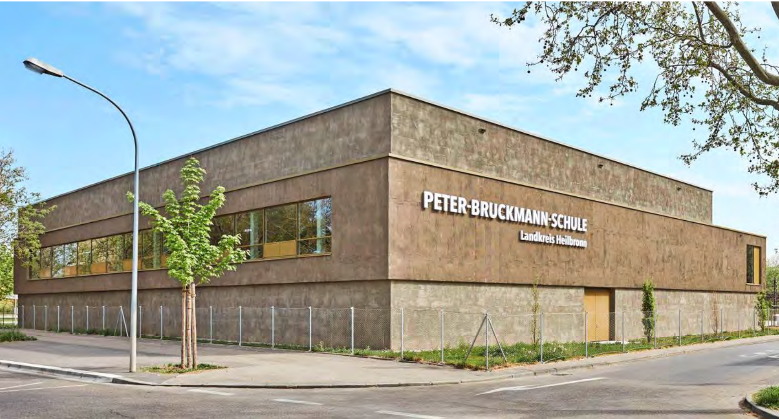
Der Sporthallen-Neubau besteht aus dem Haupttrakt mit den drei Hallenteilen und einem zweigeschossigen Nebentrakt mit Umkleiden und Toiletten. FOTOS: FOTOGRAFIE DIETMAR STRAUSS, BESIGHEIM
