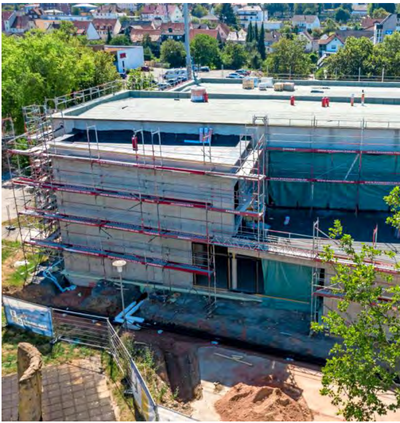
Der Neubau für das Sonderpädagogische Bildungs- und Beratungszentrum misst 40 mal 40 Meter. Im Obergeschoss liegt die neue Mensa mit 140 Sitzplätzen. FOTO: STADT TAUBERBISCHOFSHAIM
