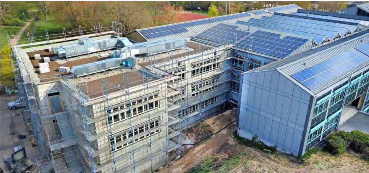
Der dreigeschossige Erweiterungsbau mit Mensa, Küche und Klassenräumen schließt an der Westseite an den Bestand an. FOTO: GEMEINDE REILINGEN
