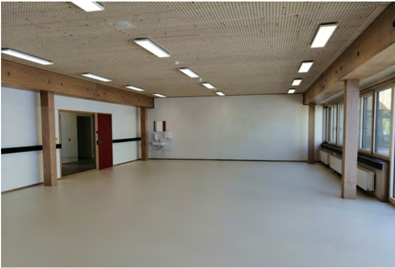
Auch im Innern arbeiteten die Architekten mit natürlichen Baustoffen: Die Wände bestehen aus Lehm und die Deckenelemente mit Schallschutzabsorbern aus Buche.
