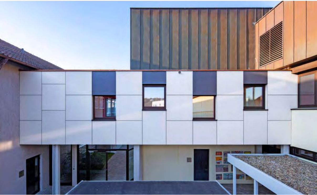
Der neue Verbindungsbau zwischen Fachklassentrakt und Schulgebäude dient im Brandfall als zweiter Fluchtweg. FOTOS: MARKUS GUHL
