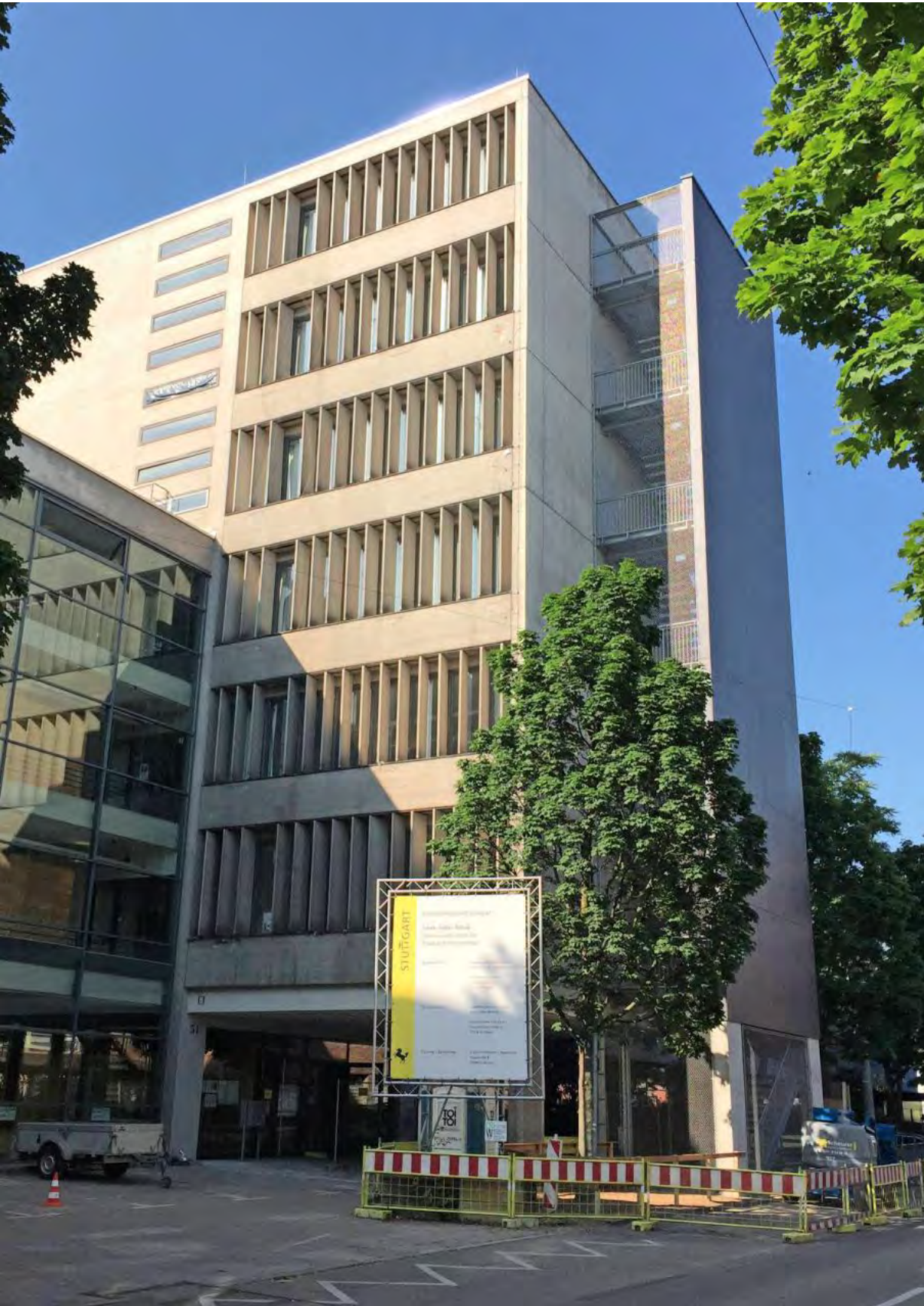
Der Hauptbauder Louis-Leitz-Schule samt Hochhaus wurde 1963 erbaut und steht unter Denkmalschutz. FOTOS: STADT STUTTGARTIS-ASS ARCHITECTEN
