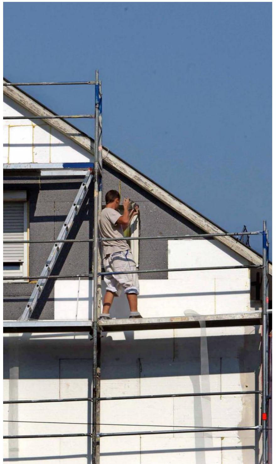
Gerade im Gebäudebereich gibt es noch viele Möglichkeiten, Energie und CO<sub>2</sub> einzusparen, etwa durch eine energetische Sanierung und entsprechende Dämmung. FOTO: SCHMIDT
