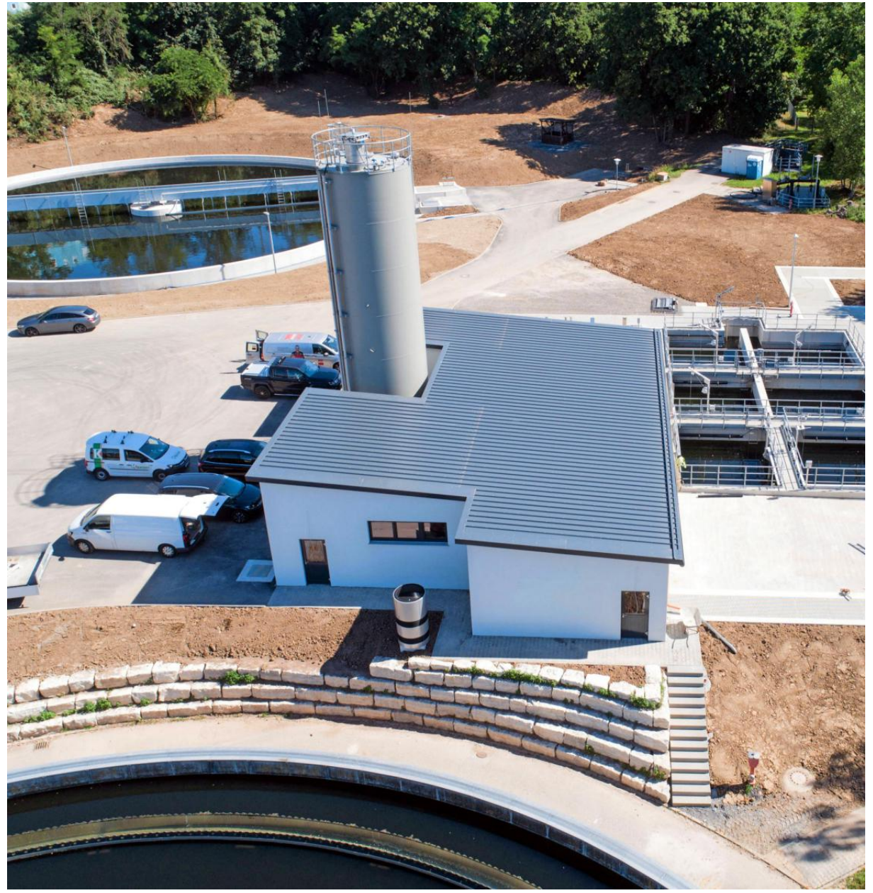
Für die vierte Reinigungsstufe wurden das Multifunktionsgebäude und das Sedimentationsbecken (im Hintergrund) neu gebaut.
