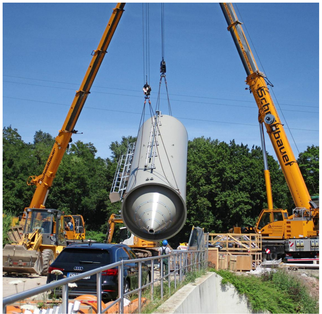
Die Aufstellung des Aktivkohle-Silos war eine sehr aufwendige Aktion. FOTOS: WEBER-INGENIEURE
