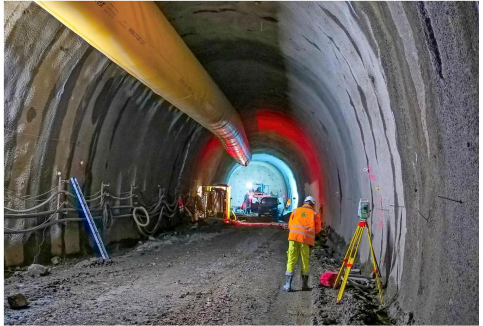
Stück für Stück arbeiten sich die Tunnelbauer in bergmännischer Bauweise durch die Röhre, die am Ende 498 Meter lang sein wird.
