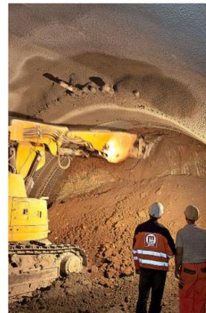
Mit je zwei Fahrspuren in zwei getrennten Röhren verläuft der Rosensteintunnel unter dem Rosensteintunnelpark und der Wilhelma (links). 750 der insgesamt 1300 Meter Tunnelstrecke wurden in bergmännischer Bauweise errichtet (oben). FOTOS: THOMAS HÖRNER
