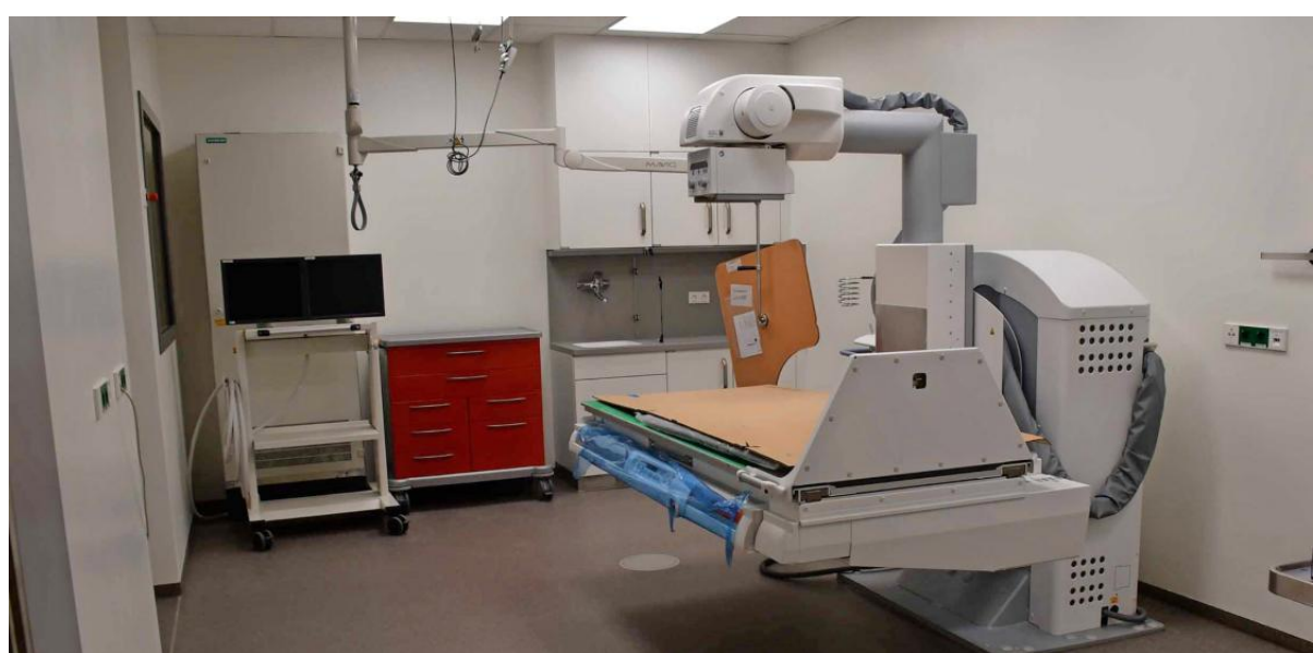
Der Neubau für die Urologie in Eberbach ist mit modernster Medizintechnik für Diagnostik und Behandlung ausgestattet. FOTO: GRN
