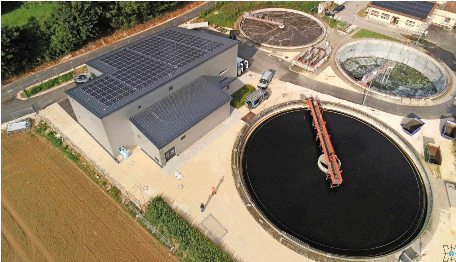
Wegen der begrenzten Fläche musste das Gebäude für die vierte Reinigungsstufe (vorne) in Halzhausen sehr kompakt geplant werden. FOTOS: WASSERMÜLLER ULM
