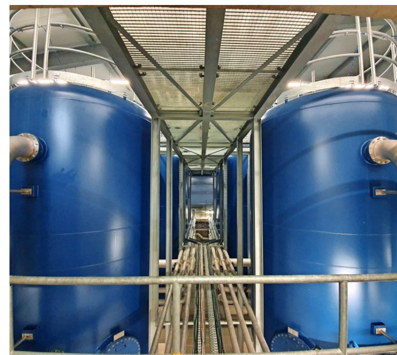
Die blauen Tanks mit Aktivkohle sind das Herzstück der vierten Reinigungsstufe.
