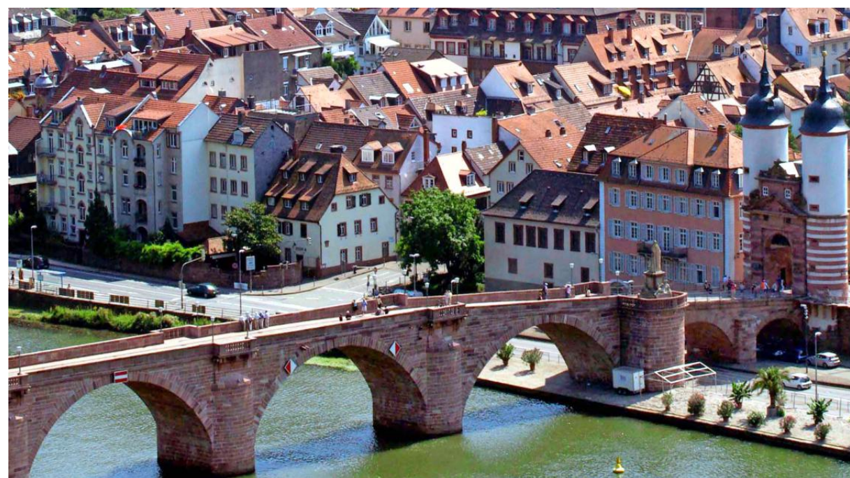
An der Alten Brücke werden in diesem Jahr die Fundamente unterhalb der Wasserlinie saniert. FOTO: SCHMIDT
