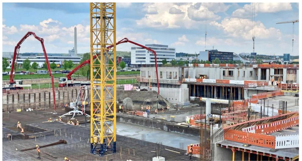
Im nördlichen Baukörper des Flugfeldklinikums wird derzeit die Bodenplatte betoniert. FOTO: KLINIKVERBUND SÜDWEST
