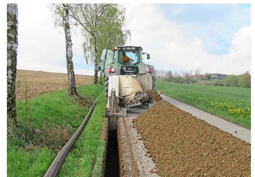
Um das Abwasser aus Unteraspach und Ruppertshofen künftig in der Kläranlage Ilshofen reinigen zu können, werden Druckleitungen verlegt.
