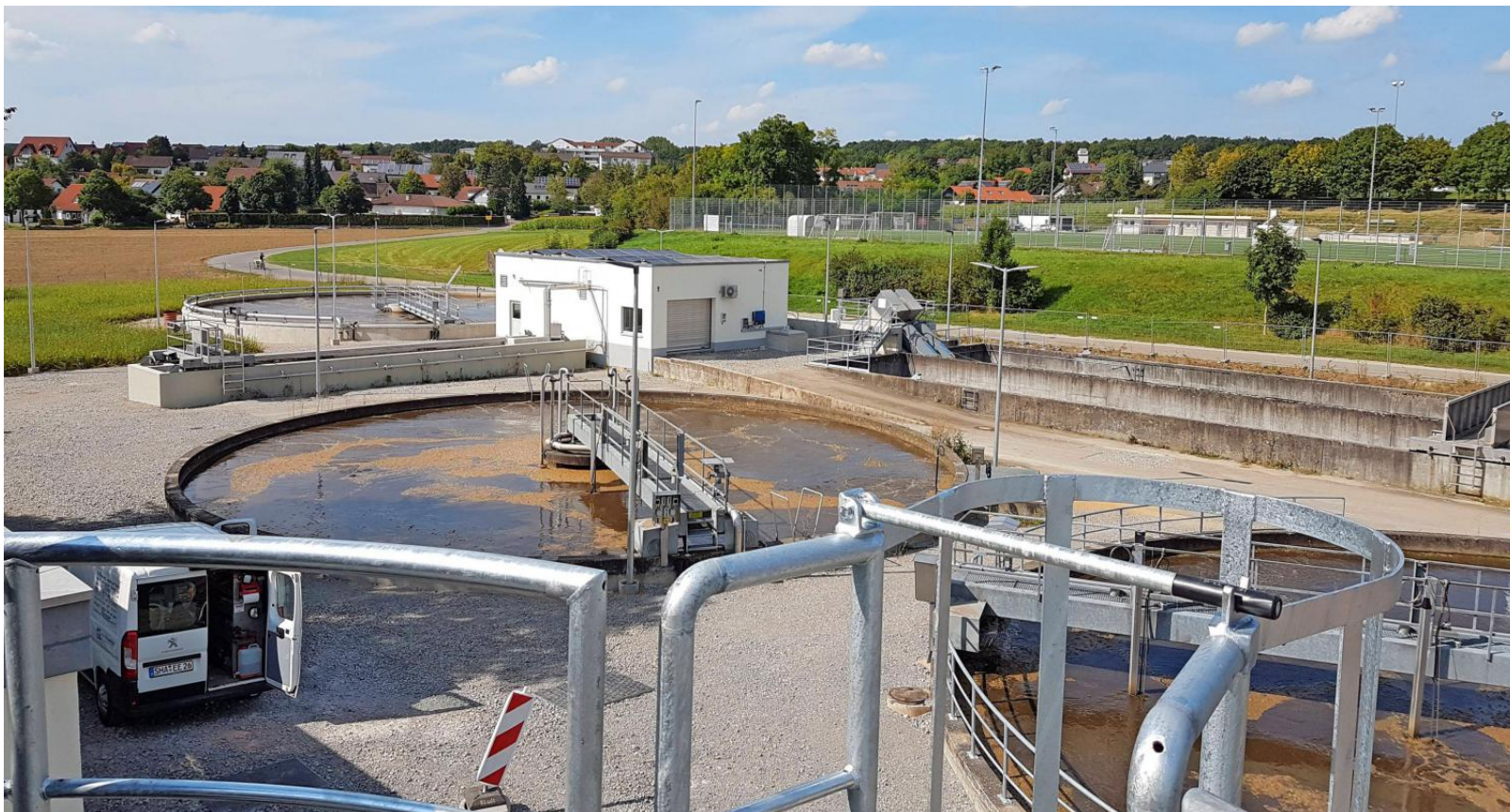
Die Kläranlage in Ilshofen wurde in den vergangenen drei Jahren erweitert, um das Abwasser aus zwei weiteren Stadtteilen reinigen zu können. FOTOS: STADT ILSHOFEN
