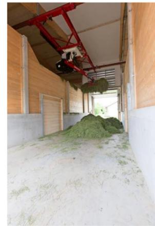
Das neue Gebäude für die Staatsdomäne Hochburg wurde vollständig in Holzbauweise errichtet (links). Ein Teil des Neubaus wird für die Lagerung und Trocknung von Heu genutzt, für dessen Transport ein Kran eingebaut wurde (oben).
