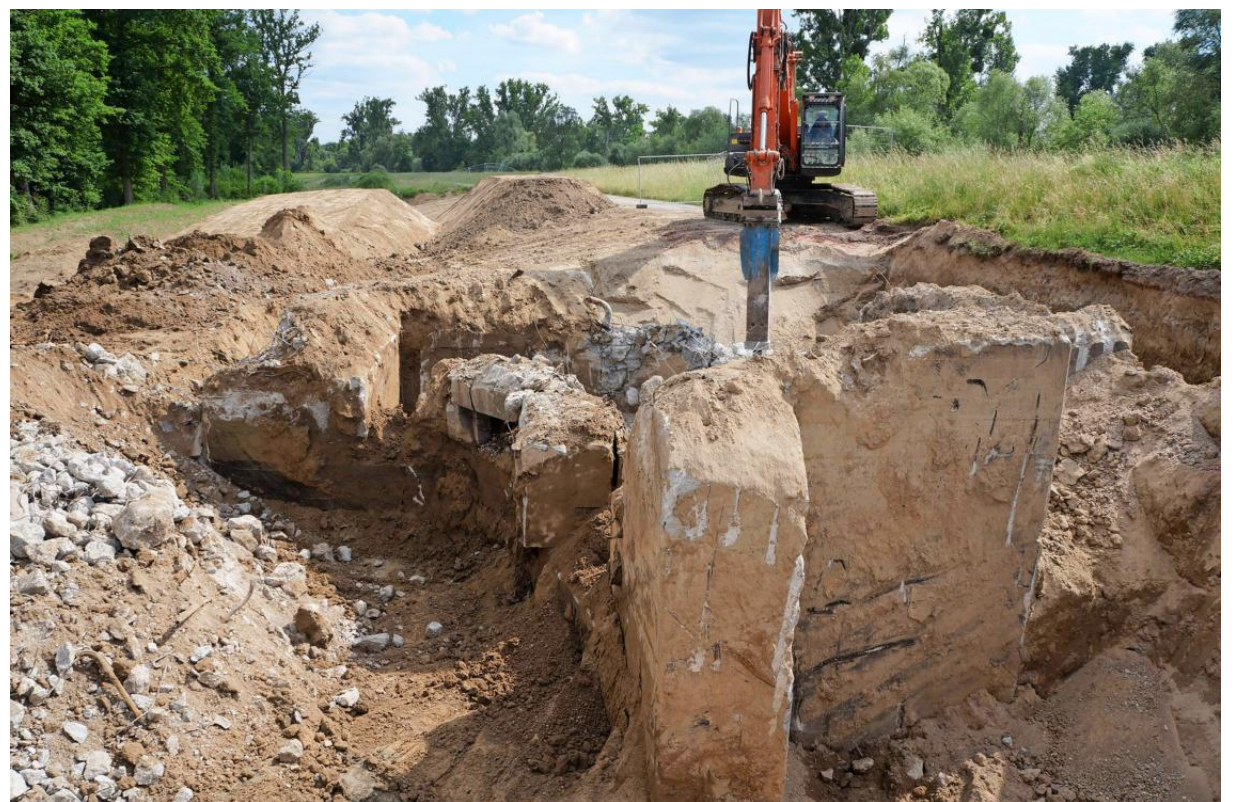
Für die Erneuerung des Hochwasserdamms mussten alte Bauwerke, wie Bunker, beseitigt werden. FOTOS: REGIERUNGSPRÄSIDIUM KARLSRUHE
