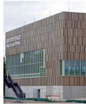
Der Boden des kleinen Beckens im neuen Sportbad lässt sich bis zur Hälfte vollständig anheben und ermöglicht so Rollstuhlfahrern den Zugang (links). Die Fassade wurde mit Metallplatten in unterschiedlichen Farben verkleidet (oben). FOTOS: SCHMIDT
