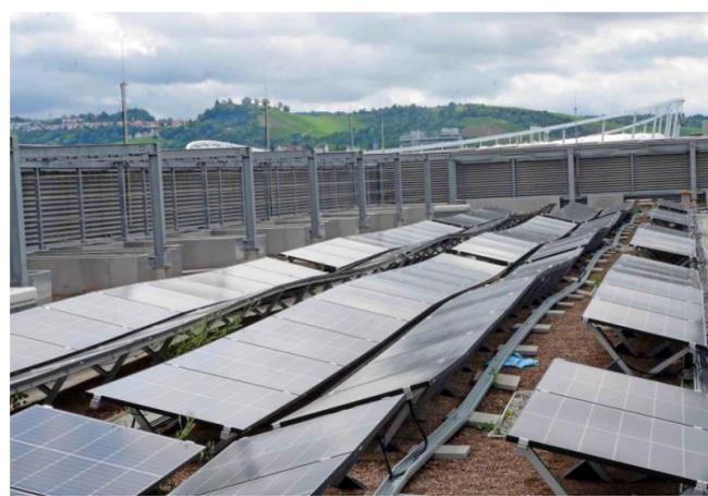
Die Photovoltaikanlage auf dem Flachdach des Gebäudes kann bis zu 150 000 Kilowattstunden Strom pro Jahr erzeugen.
