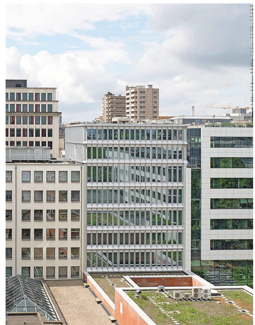
Vertikale Metalllamellen prägen die Fassade des Erweiterungsbaus für die Landesvertretung Baden-Württembergs in Brüssel (Bildmitte).
