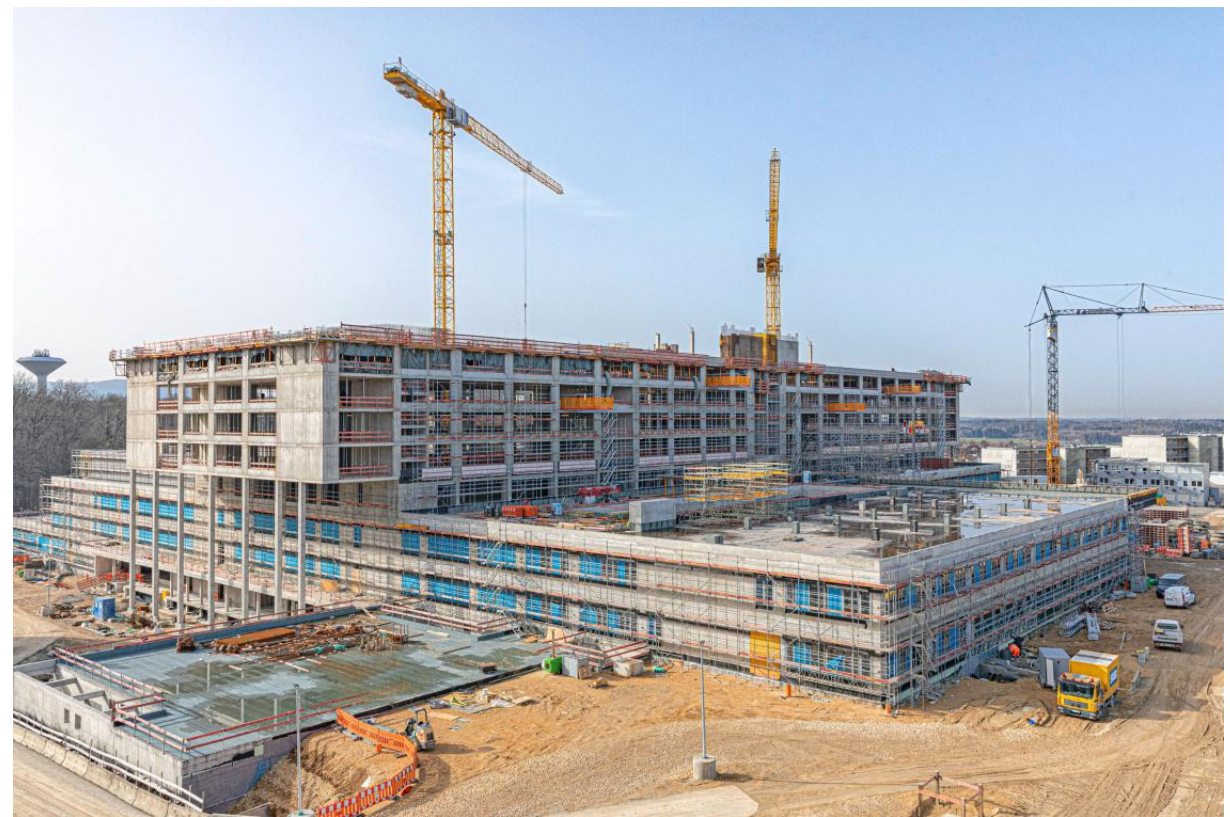
Der Rohbau für das Klinikum in Göppingen ist in den letzten Wochen abgeschlossen worden. FOTO: MAX RADLOFF
