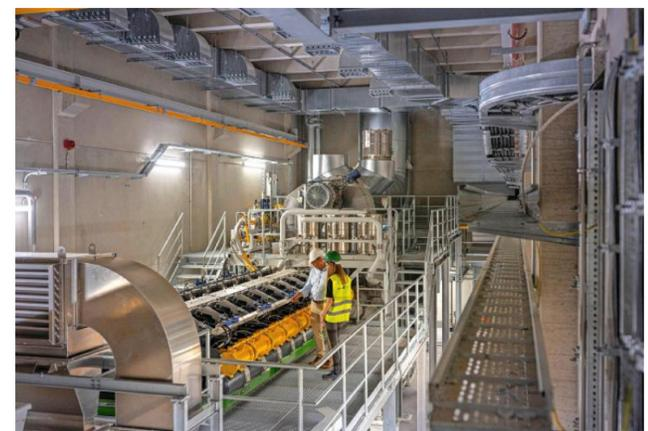
Der Einsatz der Gasmotoren im Blockheizkraftwerk ist der jüngste Schritt der Fernwärme Ulm, um die Kohlendioxidemissionen zu senken.
