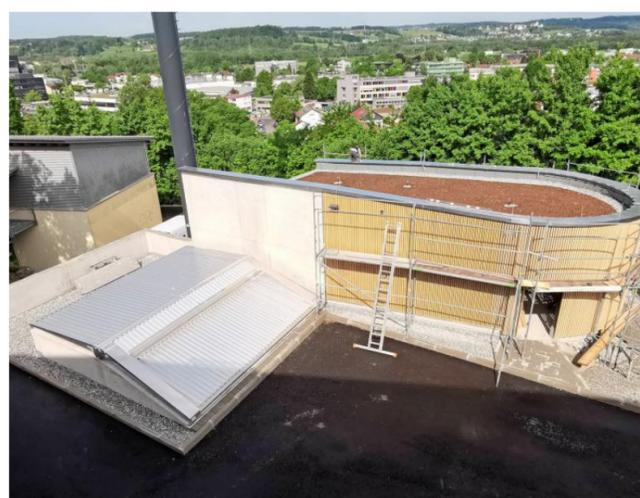
Das neue Kesselhaus ist zwölf Meter lang, zehn Meter breit und acht Meter hoch. Der Tiefbunker kann 150 Kubikmeter Holz-Hackschnittel aufnehmen. FOTO: LANDRATSAMT RAVENSBURG
