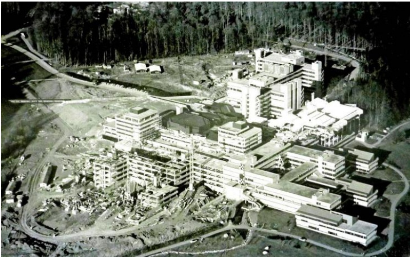
Der Universitätscampus auf dem Gießberg wurde in der ersten Hälfte der 1970er-Jahre gebaut und ist heute in vielen Bereichen sanierungsbedürftig.
