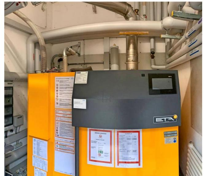
Ein Pelletkessel ersetzt in der Fachklinik Haus Weitenau nun mehrere alte Ölheizungen als Wärmequelle für die Grundlast. FOTO: ENGIE
