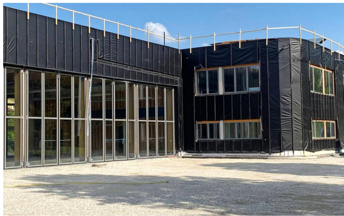
Die Fassade wird außen von einer vertikalen Holzverschalung und innen von Plattenbeplankung getragen. FOTO: GAUS ARCHITECTEN
