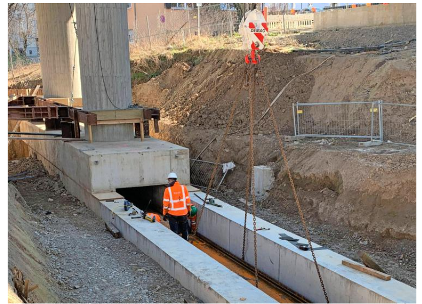
Um die Brücke samt Pfeilern und Fundamenten verschieben zu können, musste das Bauwerk um einige Zentimeter angehoben werden.
