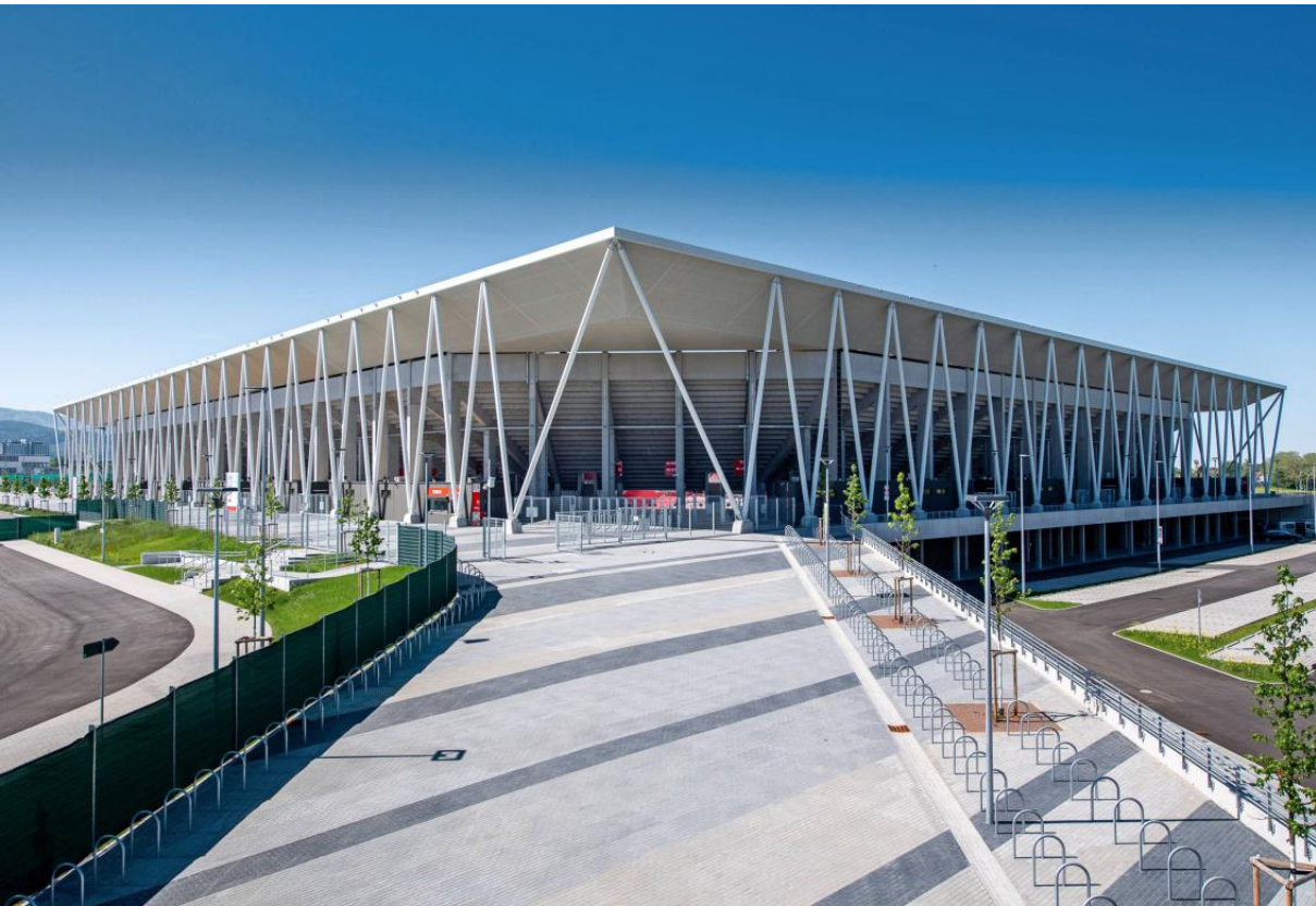
Diagonale Zugstützen halten das Dach der neuen Fußball-Arena, die offiziell Europa-Park-Stadion heißt.
