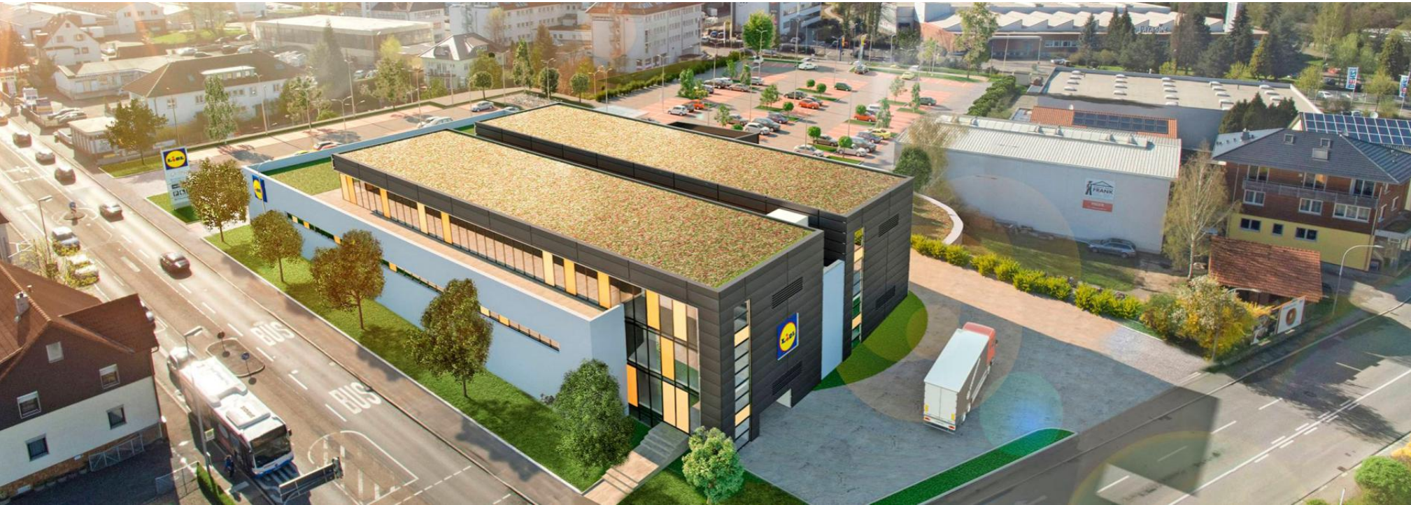
Ein Holz-Beton-Verbundtragwerk mit 25 Meter langen Holzträgern haben Bewer Ingenieure für einen Supermarkt in Winnenden entwickelt. Das Projekt wird beim Tragwerksplaner-Tag vorgestellt. FOTO: BEWER INGENIEURE
