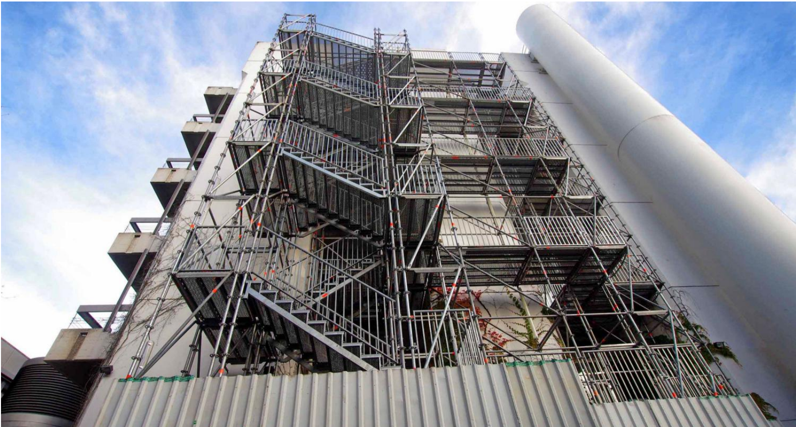
Ob bauliche Maßnahmen zum Brandschutz wie etwa Fluchttreppen bei Sanierungen erforderlich sind, lässt sich vorab mit Simulationen ermitteln. FOTOS: SCHMIDT
