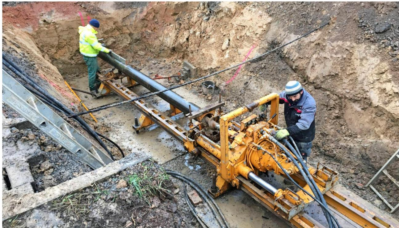
Bei der Verlegung der Leerrohre und Glasfaserkabel setzt der Zweckverband High-Speed-Netz Rhein-Neckar überwiegend auf klassischen Tiefbau. FOTOS: ZWECKVERBAND HIGH-SPEED-NETZ RHEIN-NECKAR
