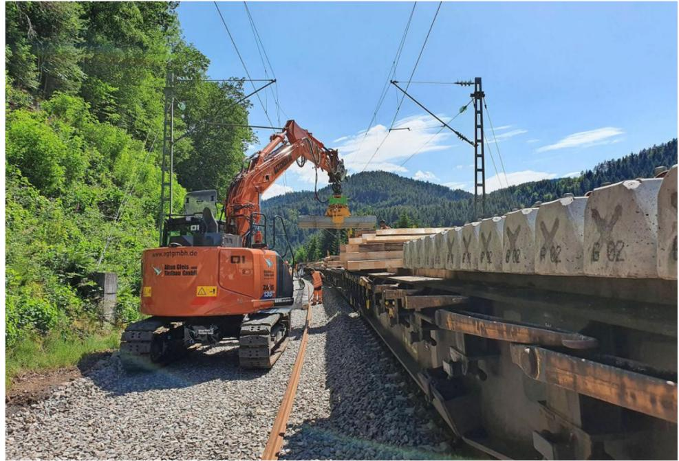
Auf dem 30 Kilometer langen Abschnitt mussten 63 000 Schwellen ausgetauscht werden. FOTOS: DEUTSCHE BAHN
