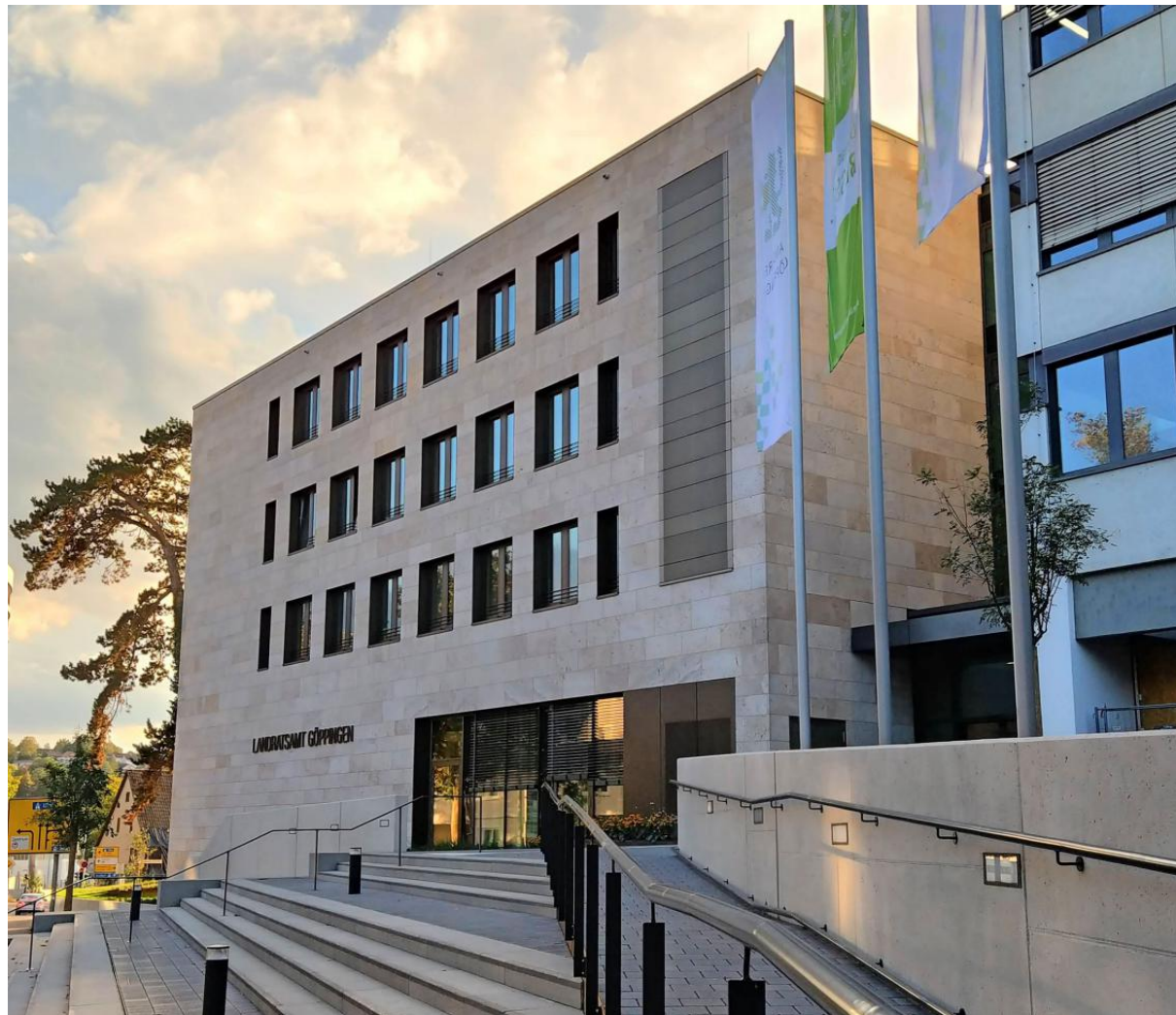
Der neue Vorplatz bildet mit der Fassade, die sich gestalterisch an den Bestand anlehnt, ein städtebauliches Ensemble. FOTO: LRAGP
