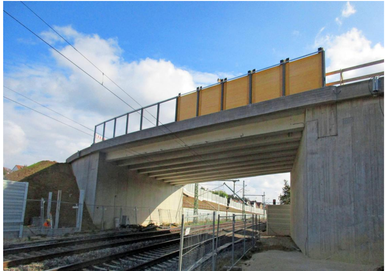
Die Brücke über der Bahnstrecke Stuttgart – Ulm wurde 2019 abgebrochen und durch einen Neubau ersetzt. FOTOS: REGIERUNGSPRÄSIDIUM STUTTGART
