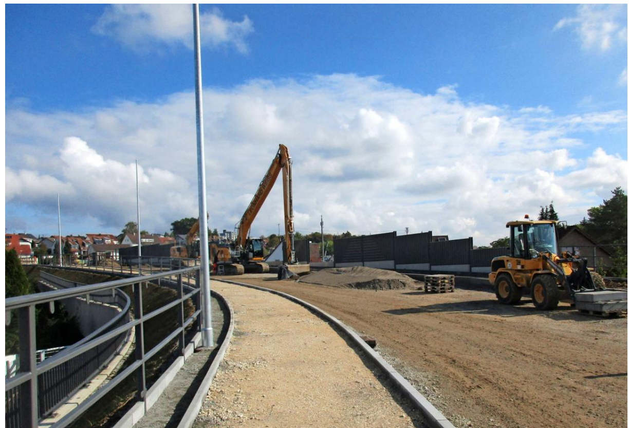
Im Rahmen der Baumaßnahmen wurden auch Geh- und Radwegführungen erneuert.
