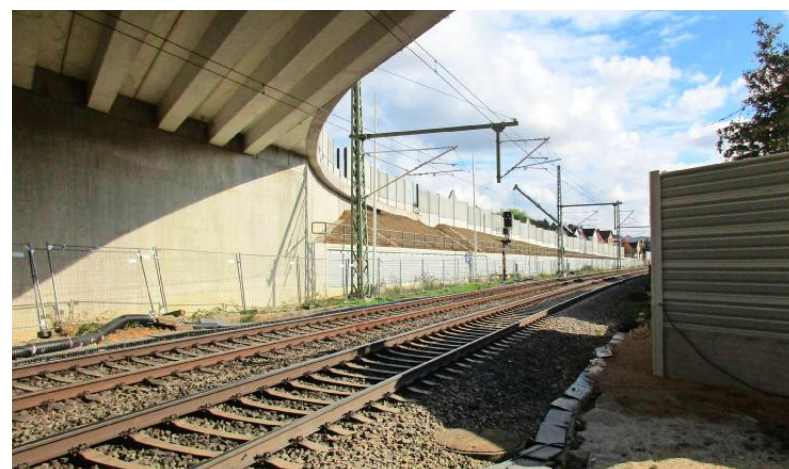
Eigenen Angaben zufolge hat die Deutsche Bahn knapp 1,3 Millionen Euro im Bereich der Schienen investiert.
